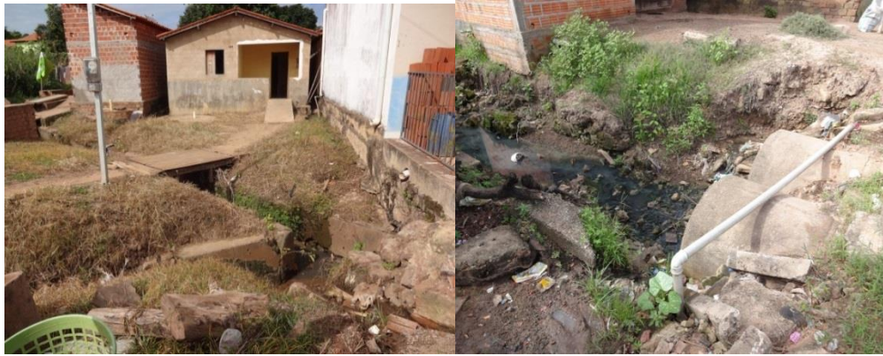
Figura 1: Área de estudo sobre as parasitoses intestinais. Esgoto correndo a céu aberto na porta das casas no Bairro Mangueira, Grajaú-MA.
