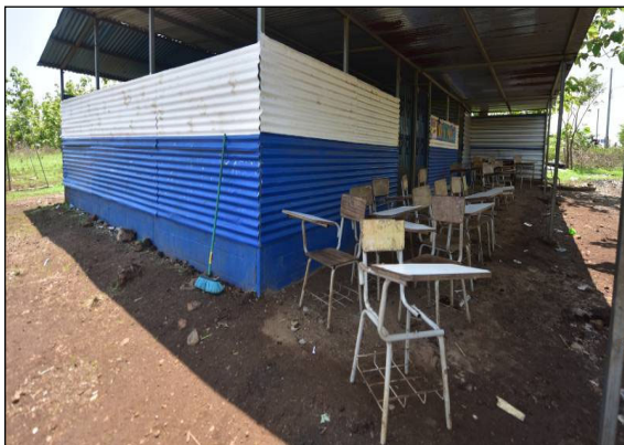
Figura 8. Instalación de un colegio en San Salvador de Sonsonate
