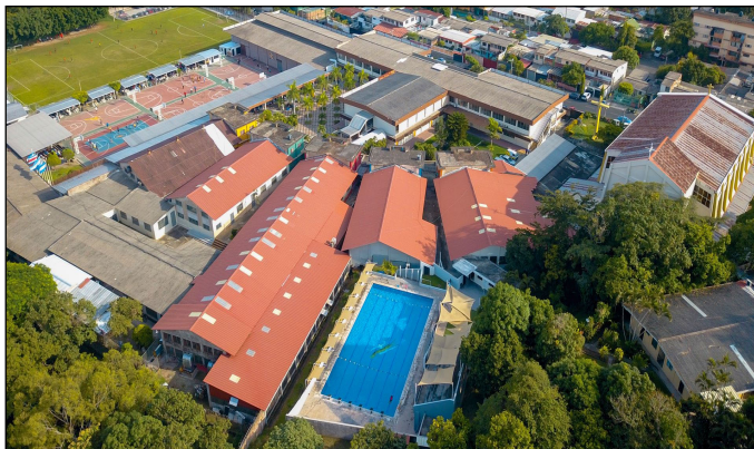
Figura 9. Instalación de una escuela en zonas rurales
