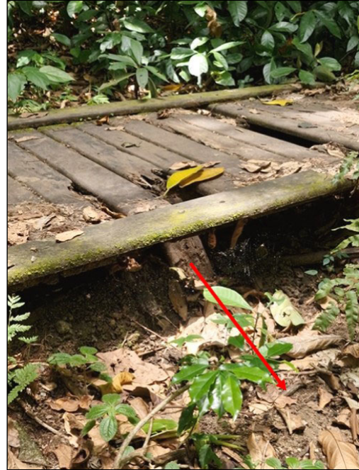
Figura 6. Erosão em túnel.
