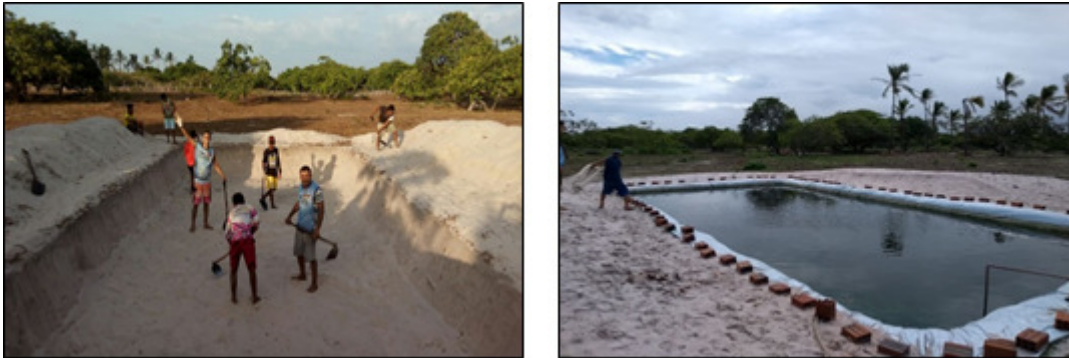
Figura 6 - Escavação do tanque e o tanque pronto e povoado na Comunidade Lagoa da Esperança.
