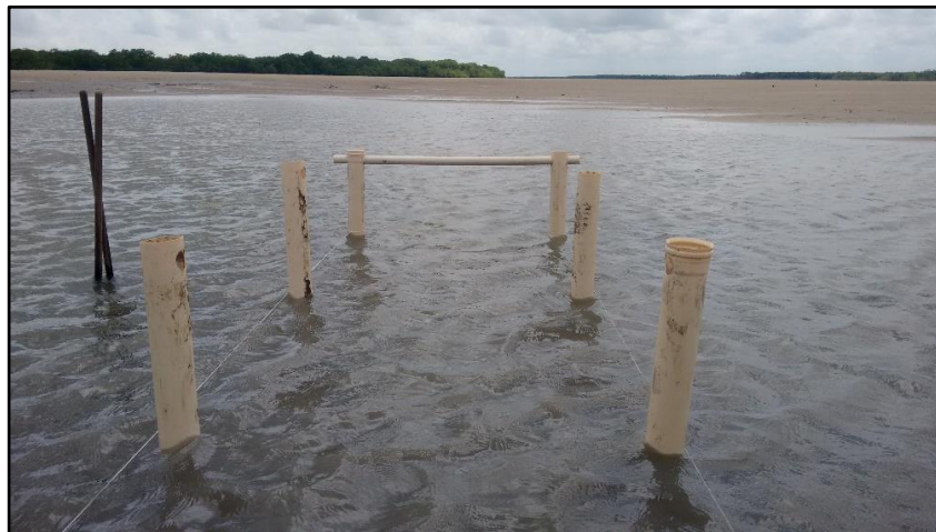
Figura 6. Instalação da primeira cama
