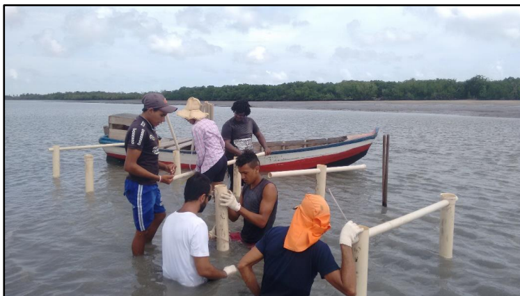
Figura 7. Instalação da segunda cama.
