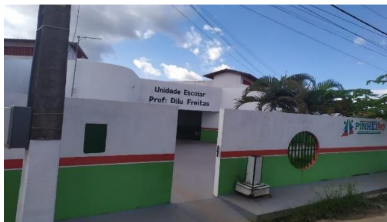
Figura 1. Foto da faixa da Unidade Escolar Prof a . Dilu Freitas, Pinheiro – MA.
