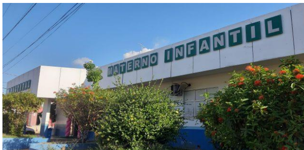
Figura 1. Fachada do Hospital Materno Infantil, Bacabal-MA.
